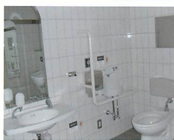
● 多機能トイレの設置 (可動式手すり、オストメイト対応設備など)
